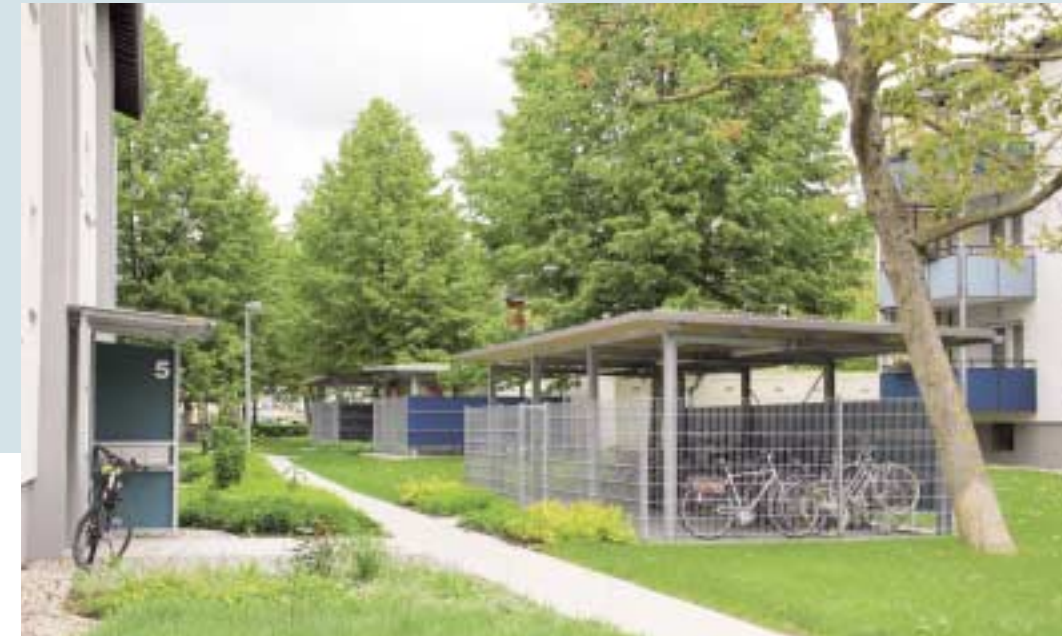
Neue Fahrrad-abstellanlagen, Im Ferning, Ettlingen
