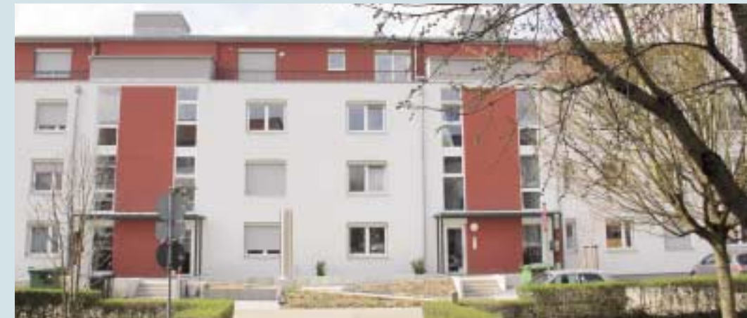
Neubau, Edelbergweg 4-6, Ettlingen
