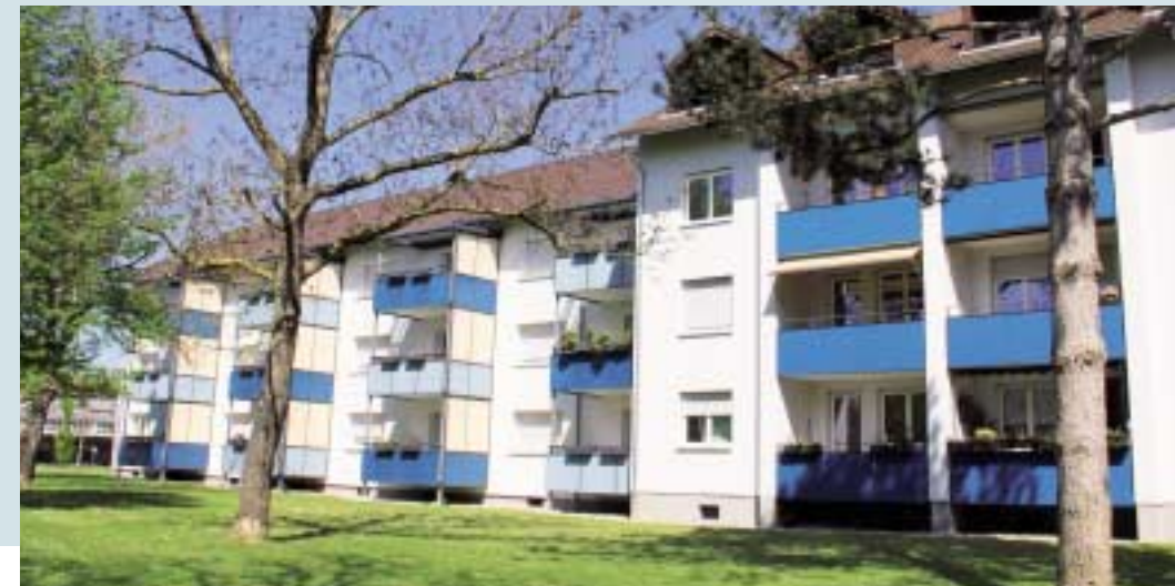
Im Ferning 28/30/30a, Ettlingen
