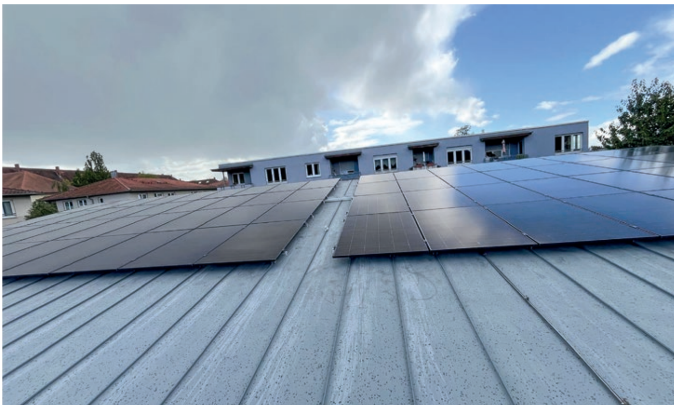
Im Herbst 2024 installierte die BEG auf dem Dach des Kindergartens Vicenzius 2 in Ettlingen eine Photovoltaikanlage mit 30 kWp.
